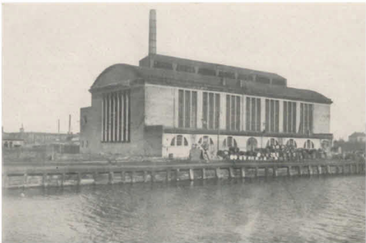
Abbildung 40: Zinkhütte, historische Aufnahme
