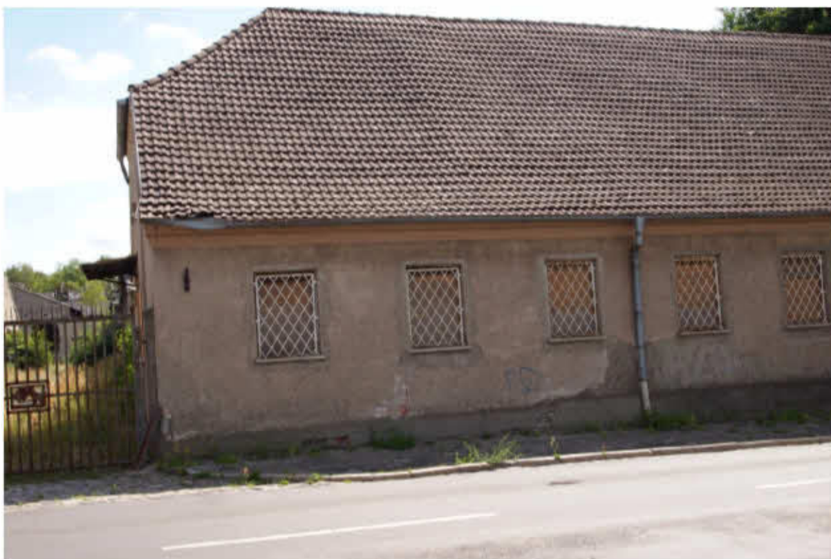
Abbildung 36: Kurzwalmdachhaus an der Altenhofer Straße
