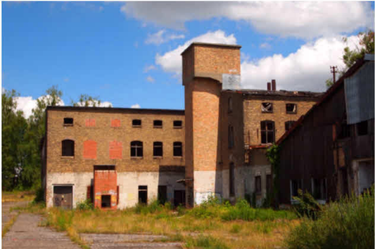
Abbildung 38: Anbau Abfallmagazin Südseite
