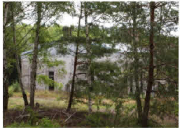
Abbildung 18: Baumbestand und Anbau Abfallmagazin
