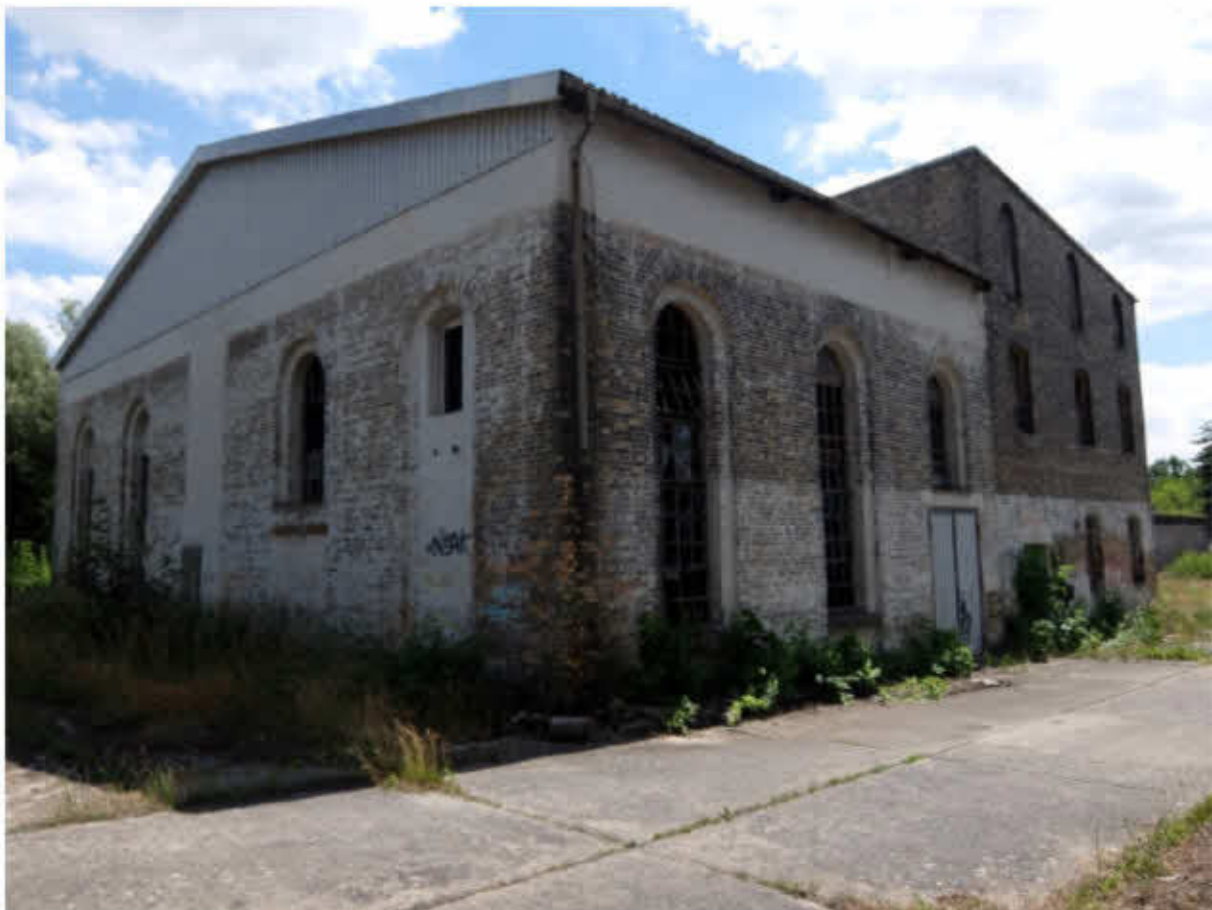
Abbildung 39: Anbau Abfallmagazin / Tiegelfabrik Nordseite
