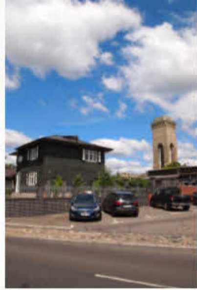
Abbildung 12: Kupferhaus und Wasserturm Finow
