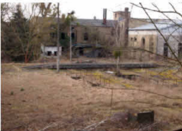
Abbildung 17: Zentrale Gebäude Messingwerk
