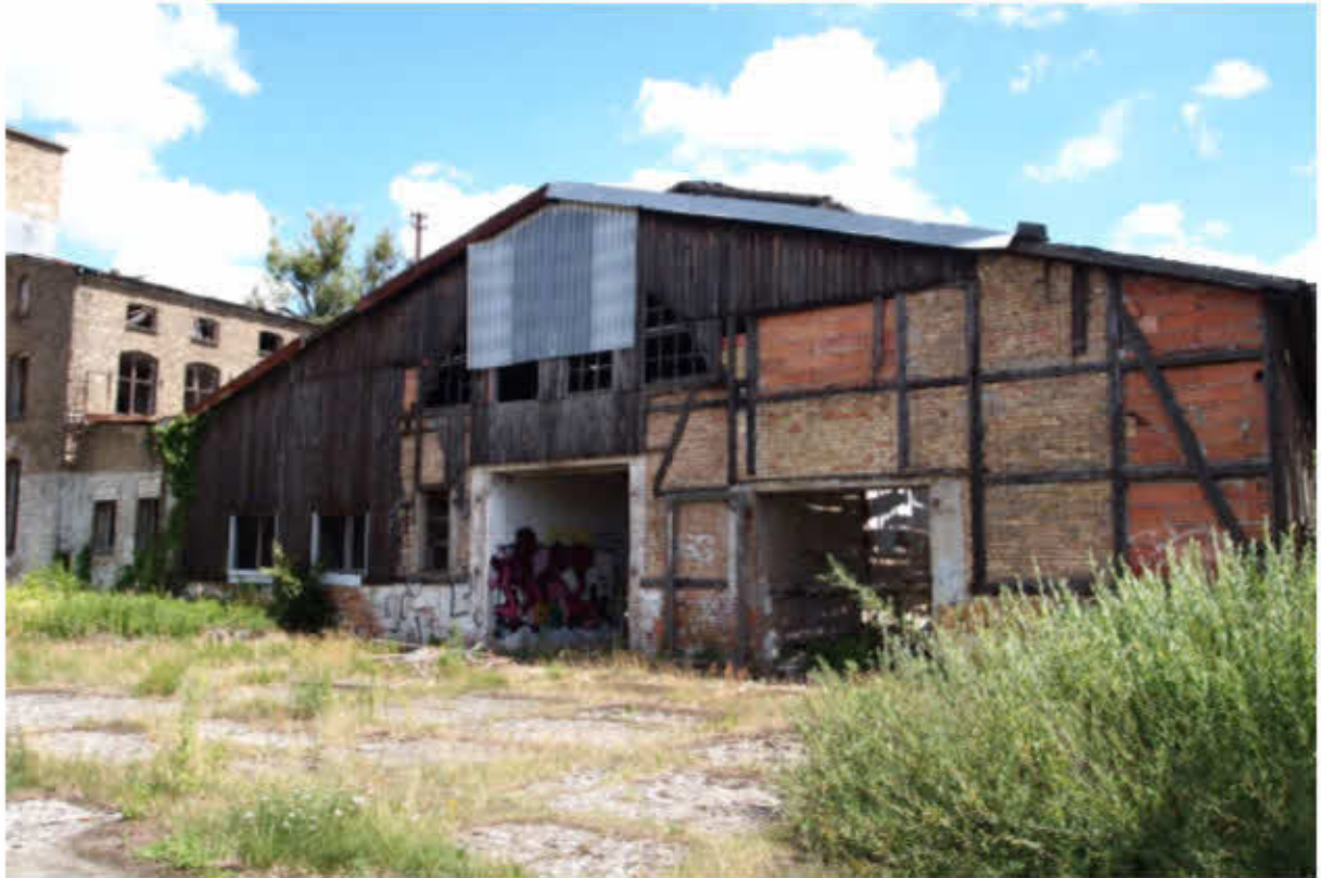
Abbildung 34: Eingang West Abfallmagazin
