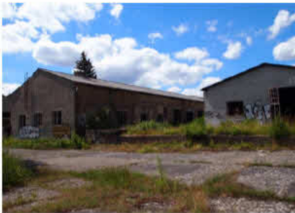
Abbildung 15: Anbau Abfallmagazin und Bahnwartung
