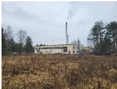
Abbildung 8: Blickrichtung Heizkraftwerk im Südwesten
