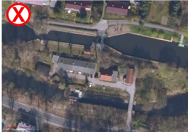
Schleuse Kupferhammer Zwillingsschleuse noch als Wehr vorhanden
