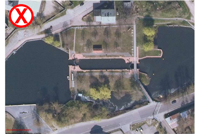
Stadtschleuse Eberswalde Neubau in historischer Form und Bauweise
