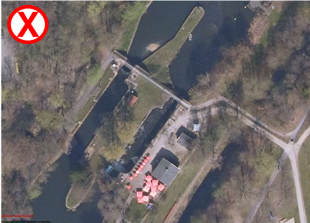
Schleuse Drahthammer Zwillingsschleuse noch als Wehr vorhanden
