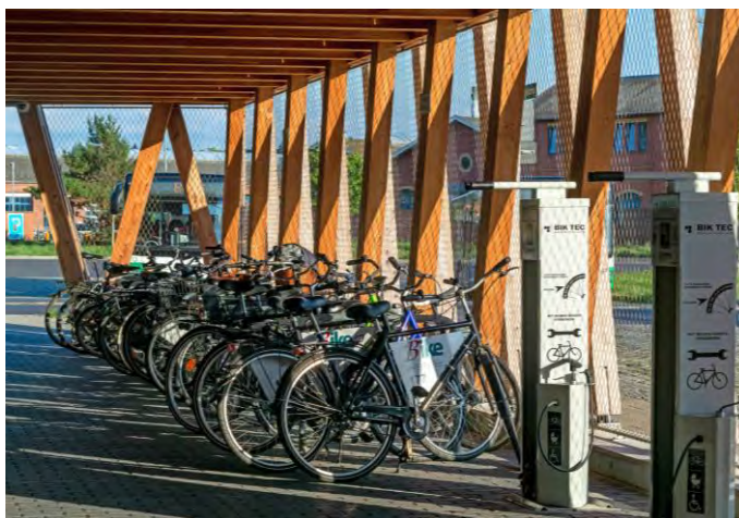
Abbildung 65: Reparaturstationen im Fahrradparkhaus © Andreas Fink, MIL
