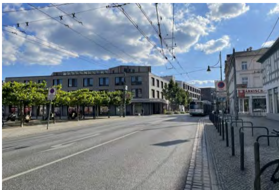
Friedrich-Ebert-Straße, Blickrichtung Südwest
