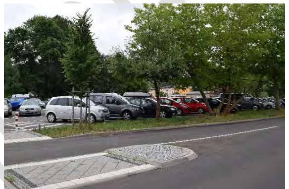
Blick auf den Parkplatz
