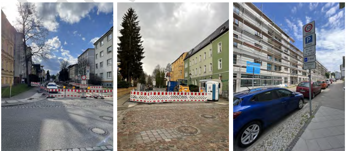
Abbildung 19: Baustelle in der Carl-von-Ossietzky-Straße und Goethestraße
