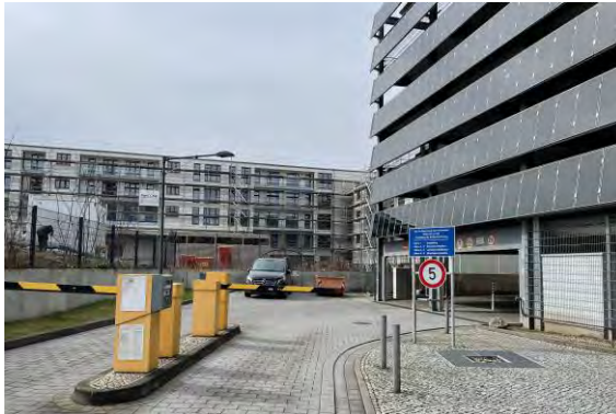
Einfahrt/ Ausfahrt Goethestraße
