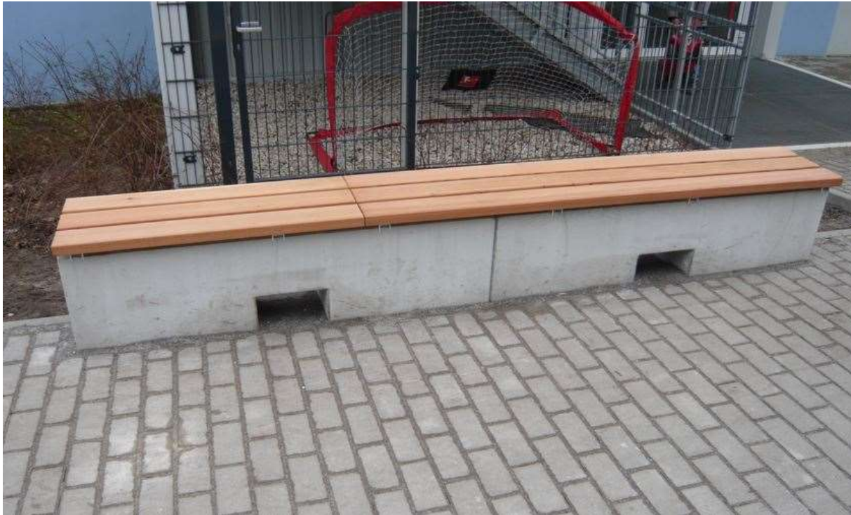
Sitzblock aus Beton zur Böschungssicherung bei Eiche
