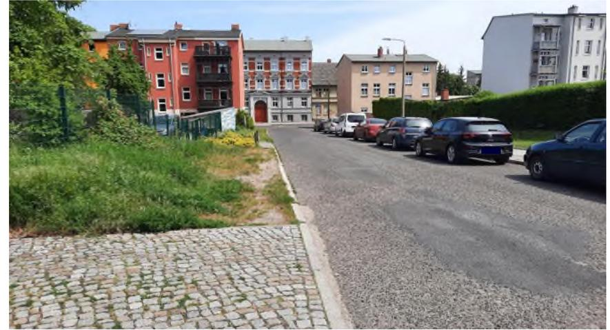
Die Fahrbahn ist gekennzeichnet durch Unebenheiten und deutliche Schäden im Asphalt (Schlaglöcher, Risse, Flickungen, Ausmagerung des Asphaltes).
