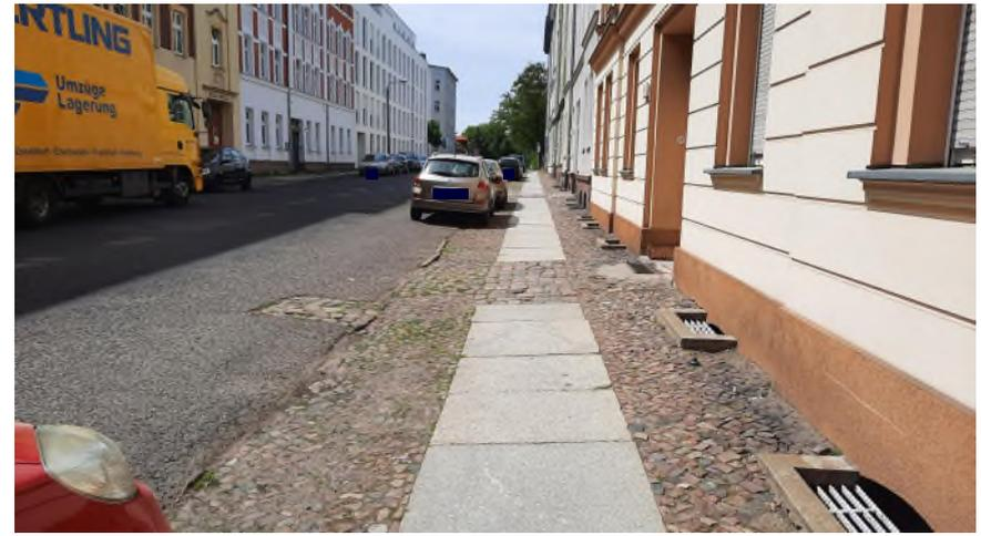
Der Gehweg ist für Fußgänger die Haupteinschließung der Wohnbebauung. Er weist große Schäden sowie starke Unebenheiten auf, gleiches gilt für einen Großteil der Zufahrten. Diese Schäden verringern die Benutzbarkeit sowie die Verkehrssicherheit insbesondere für die Kinder sowie für Menschen mit Behinderung.
