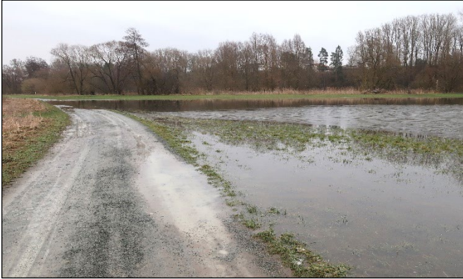
Abbildung 64: Überflutete Wege. © M. Olonscheck.
