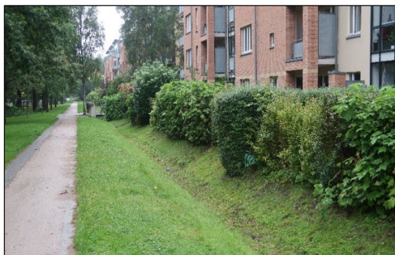
Abbildung 75: Mulden sorgen für ausreichend Feuchtigkeit in der Fläche. © M. Olonscheck.
