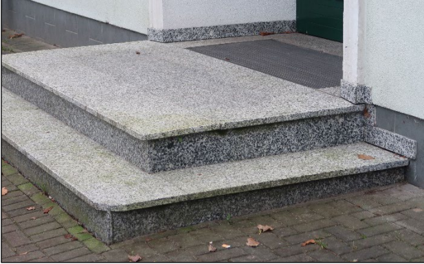
Abbildung 70: Erhöhte Eingänge verhindern ein Eindringen von Regenwasser. © M. Olonscheck.
