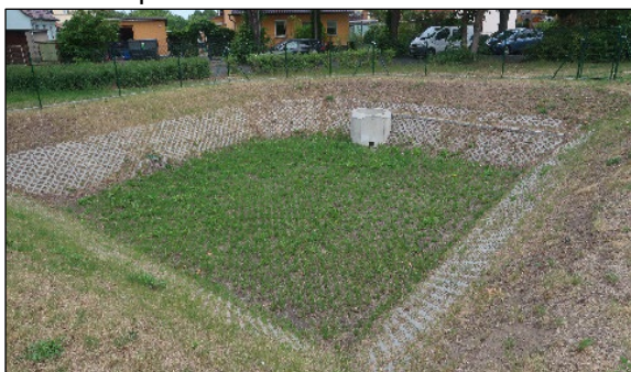
Abbildung 22: Regenrückhaltebecken an der Schönholzer Straße. © M. Olonscheck.
