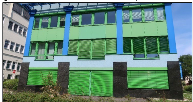
Abbildung 5: Gebäudeverschattung. © M. Olonscheck.
