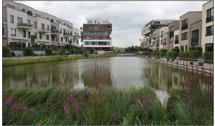
Abbildung 76: Schwammstadt Quartier 52° Nord. © M. Olonscheck.
