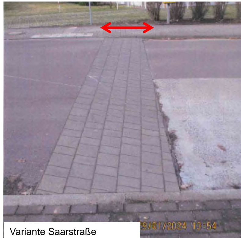
Anrampung Betonpflaster Miniphase 1,20 - 1,50 m
