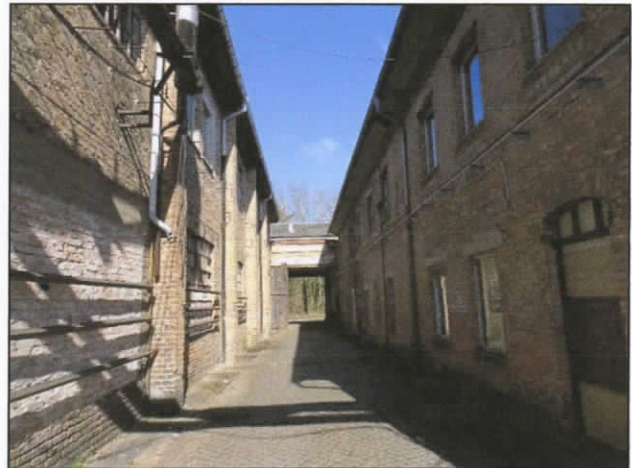
Bebauung aus der Zeit der Fabrikgründung
