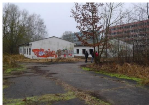
Abb. 2 Gebäudebestand Stand Januar 2022 2
