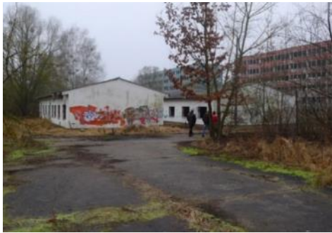
Abb. 4 Gebäudebestand Stand Januar 2022 3
