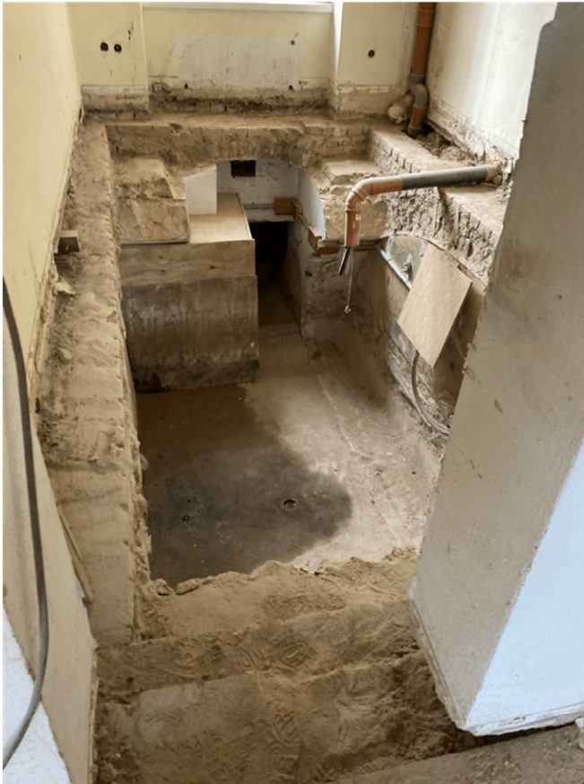
Bereich neuer Aufzug, EG
