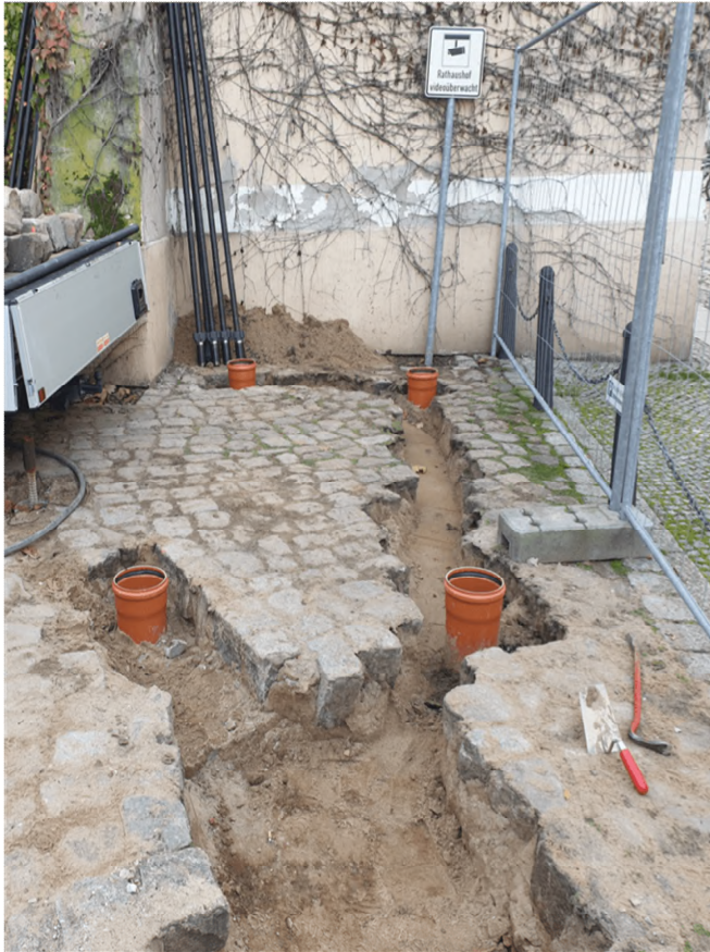
Bereich neuer Treppenanbau, Hof
