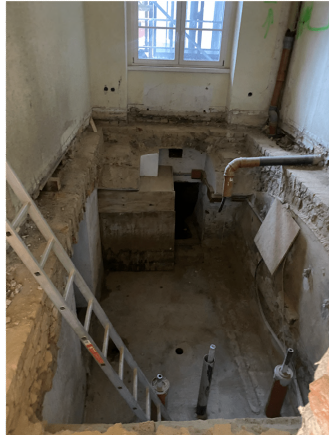
Bereich neuer Aufzug, EG
