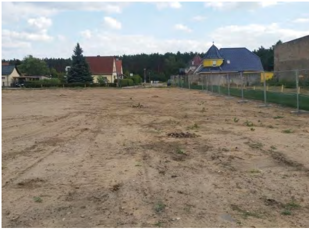
Bild 9: Die nordöstliche Teilfläche nach der Sanierung, Blick in Richtung Jahnstraße/ SO (02.07.2019)
