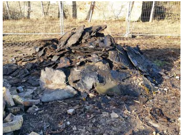
Bild 18: Ausgebauter und deklarerierter Haufen mit teerhaltiger Dachpappe (12.02.2019)
