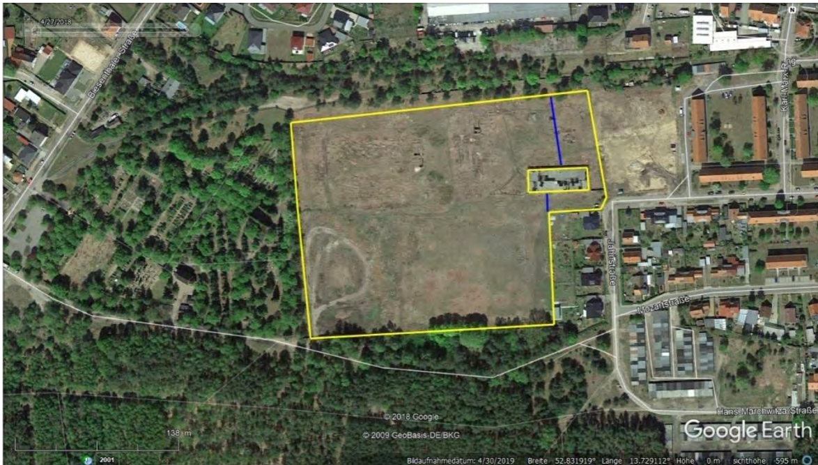
Abbildung 4-4: Baufeld 2 mit gezäuntem Gebäude (Ostteil) und 1. Vergrämungssegment, Luftbildbasis © 2009 GeoBasis DE/BKG © 2018 Google earth
