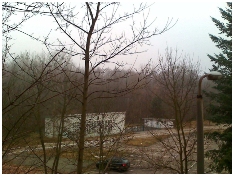
Abbildung 9: Blick zum Abwasserpumpwerk und Trafo
