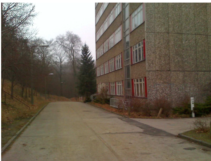
Abbildung 2: Böschungsbereich zum Sportzentrum Westend
