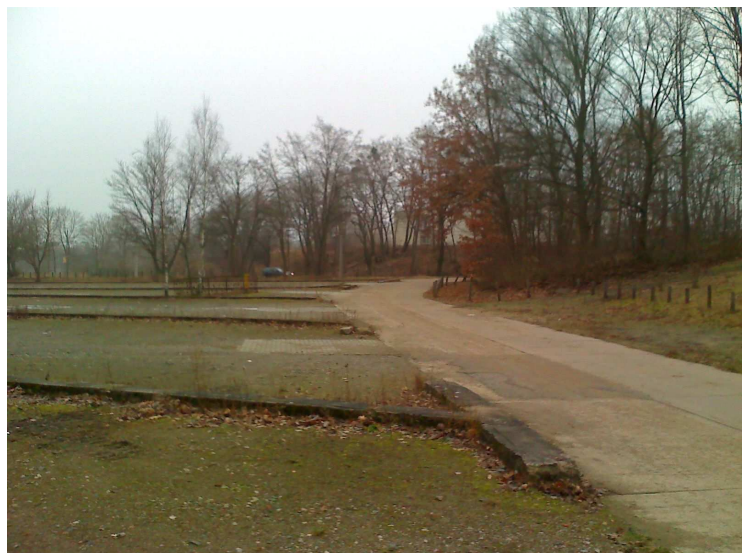
Abbildung 11: Blick vom Grundstück In Richtung Heegermühler Straße- Zufahrt 2
