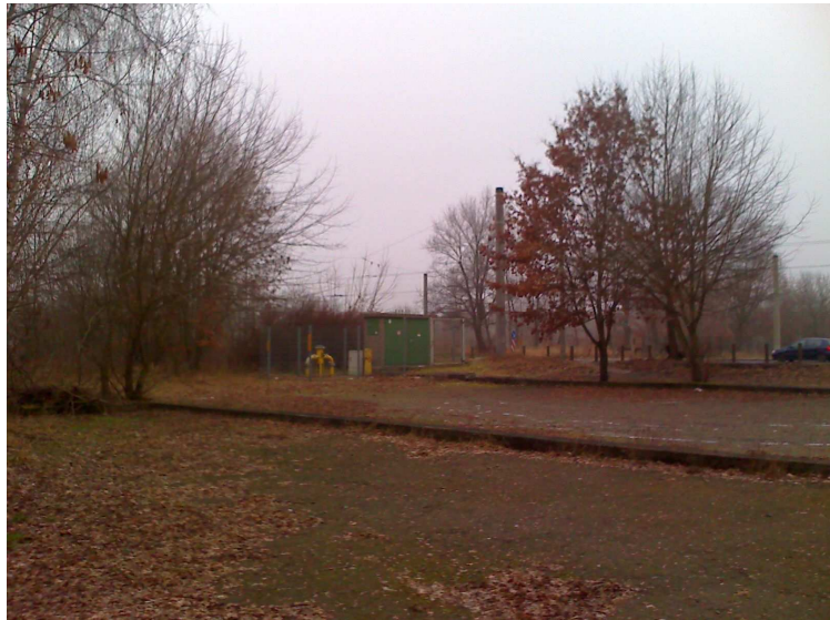
Abbildung 8: Gasreglerstation an der westlichen Bearbeitungsgrenze
