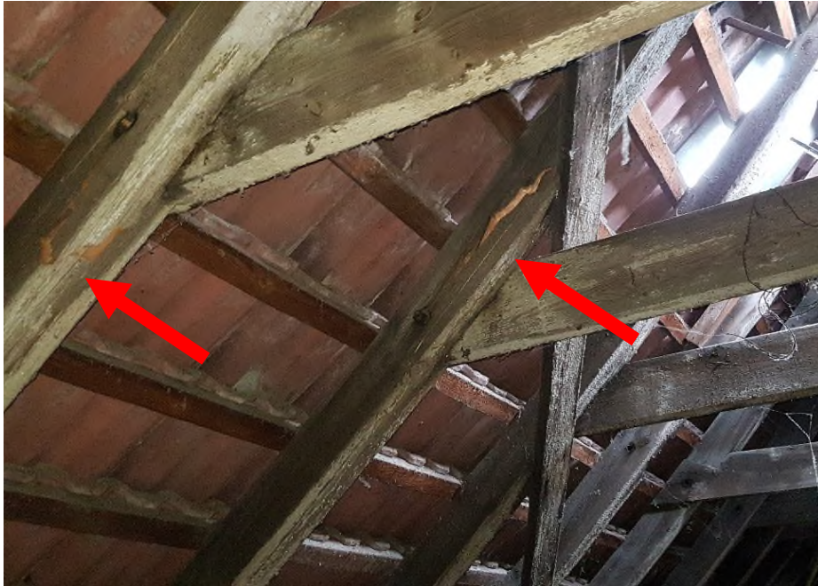
Bruch der Sparren im Bereich der Kehlbalken
