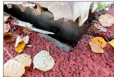
Entwässerungsrinne defekt
