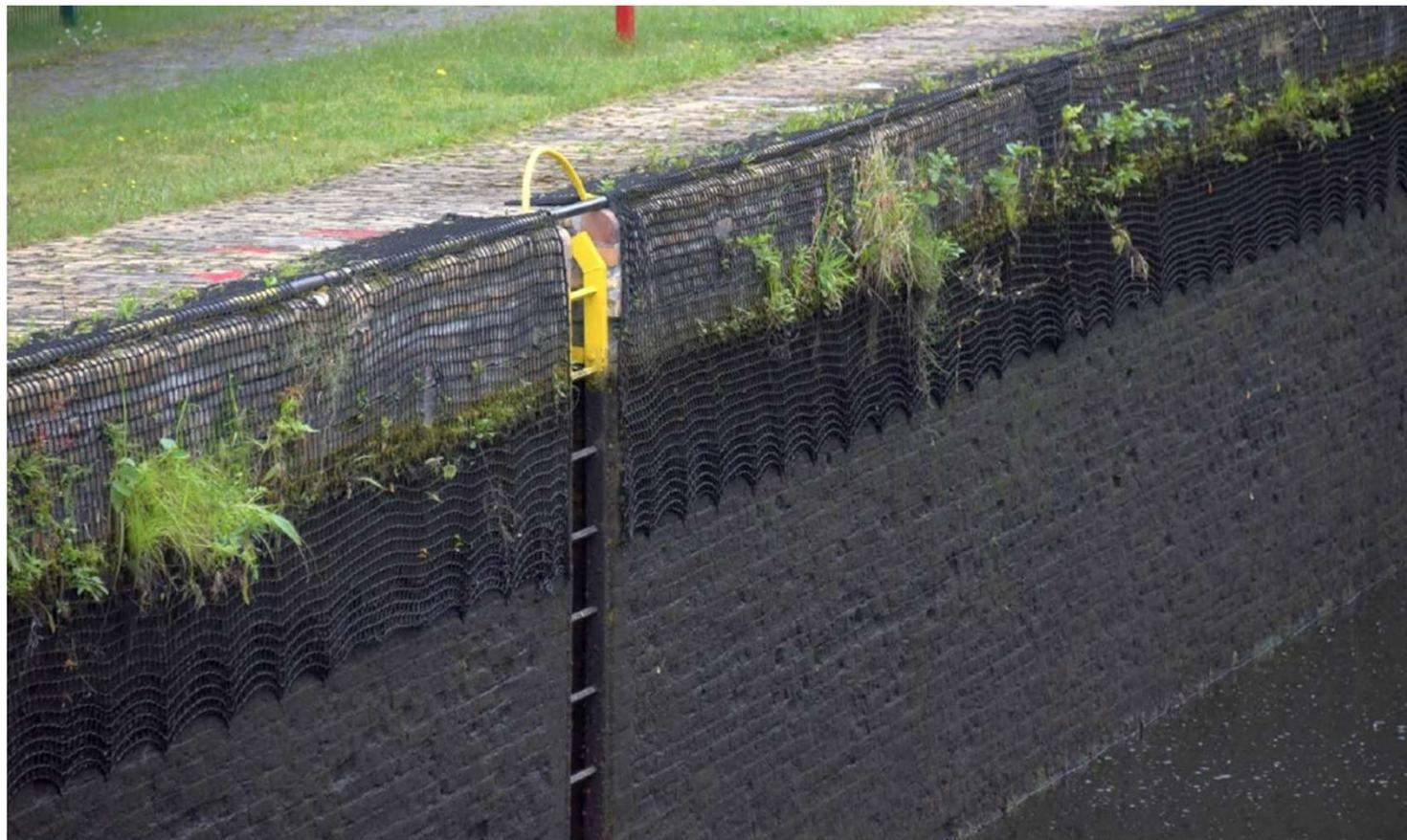
Schleuse Leesenbrück - Netze als Sicherung gegen herabfallende Teile des Kammermauerwerkes, darunter großflächig erodiertes Kammermauerwerk.
