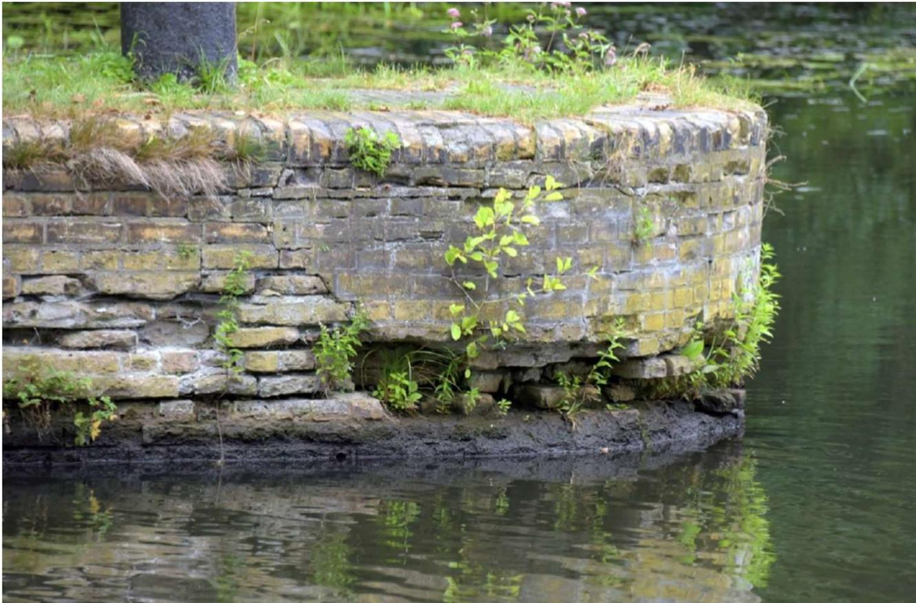
Schleuse Wolfswinkel, stark erodiertes Mauerwerk an der Vorhafen-Uferwand im Unterwasser
