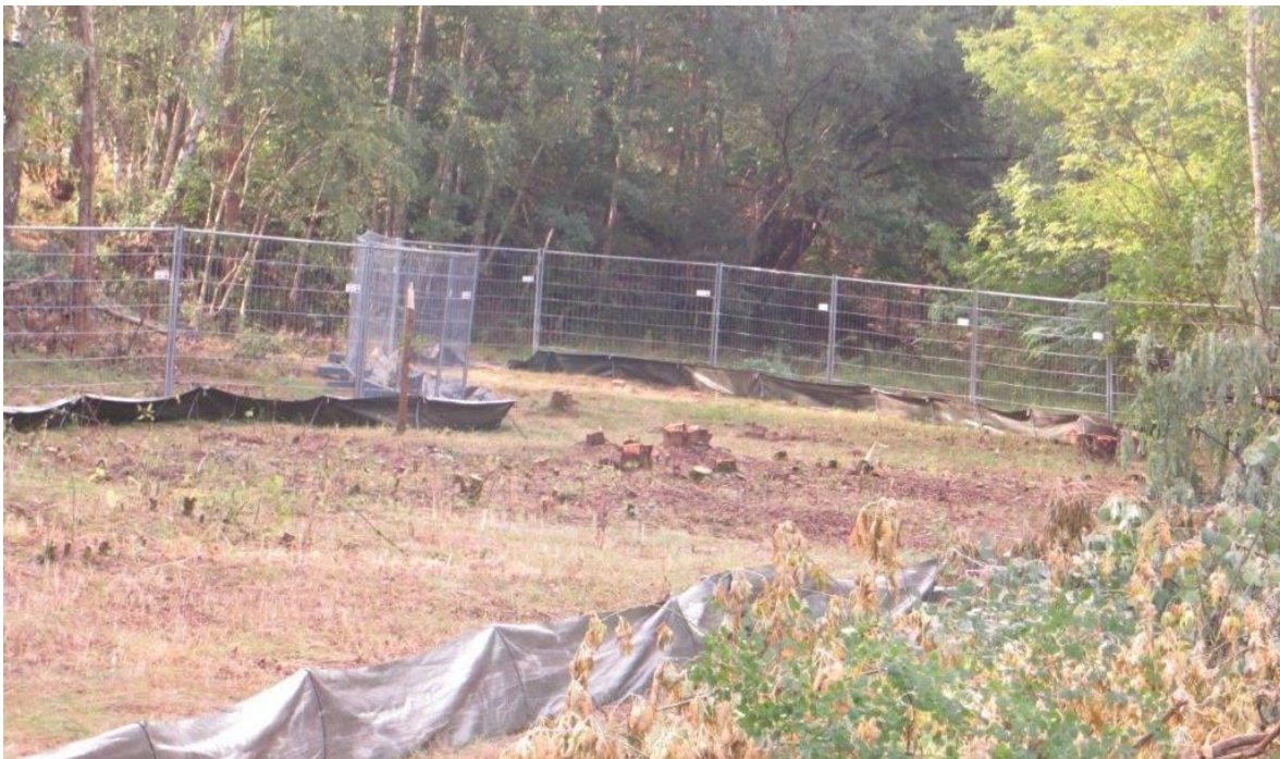
Abbildung 3-2: Bauzaun als Schutz vor Beschädigung des Schutzzaunes auf einer einem Fußweg zugewandten Seite (LEGUAN GMBH 2016b)
