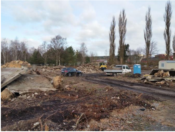
Bild 19: Ausbau und Deklaration der Altlasten auf der Fläche des 1 BA (12.02.2019)
