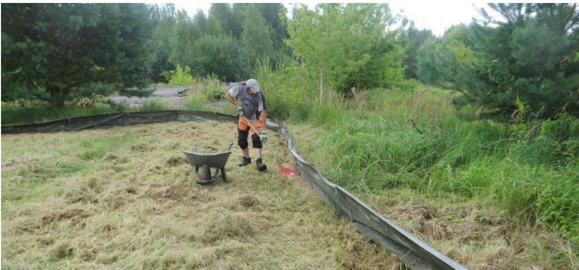
Abbildung 3-5: Abdichten des Zauns mit Sand (LEGUAN GMBH 2016b)
