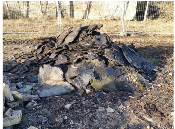
Bild 18: Ausgebauter und deklarerierter Haufen mit teerhaltiger Dachpappe (12.02.2019)
