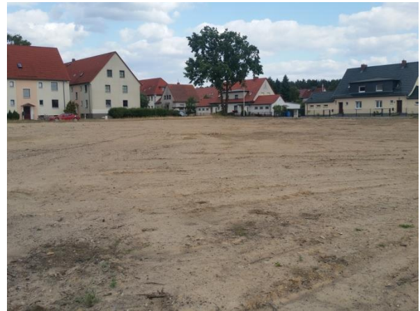
Bild 10: Die nordöstliche Teilfläche nach der Sanierung, Blick in Richtung der Wohnblöcke des Karl-Marx-Ring/O (02.07.2019)
