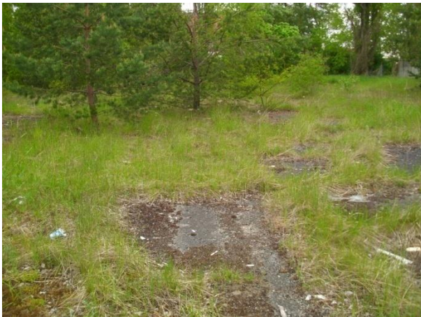
Bild 3: Beispiel eines zugewachsenen, betonierten Wegs (16.05.2017)
