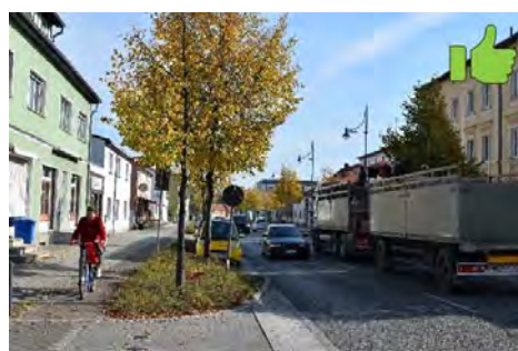
Abbildung 35: Aufpflasterung in Eberswalder Straße
