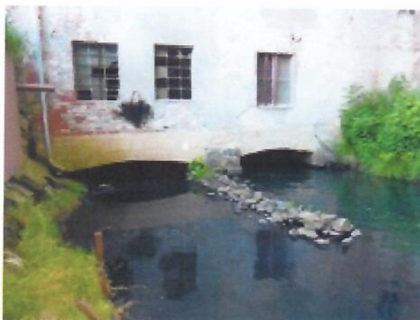
Bild 3: Ansicht von Osten (Unterlauf); in der linken Arche befindet sich der Turbinenauslauf, in der rechten Arche könnte das Wasserrad installiert werden
