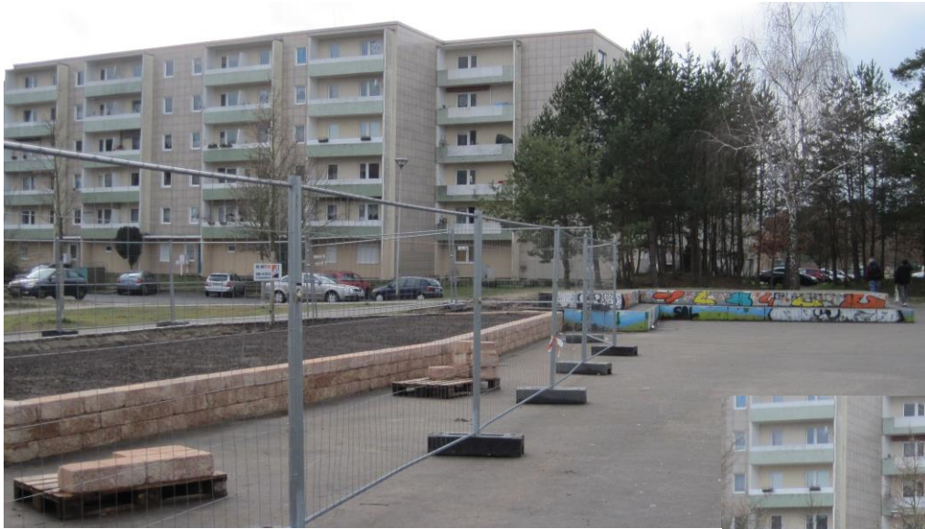
Aktuelle Bilder von der Baustelle (9. März 2020)
