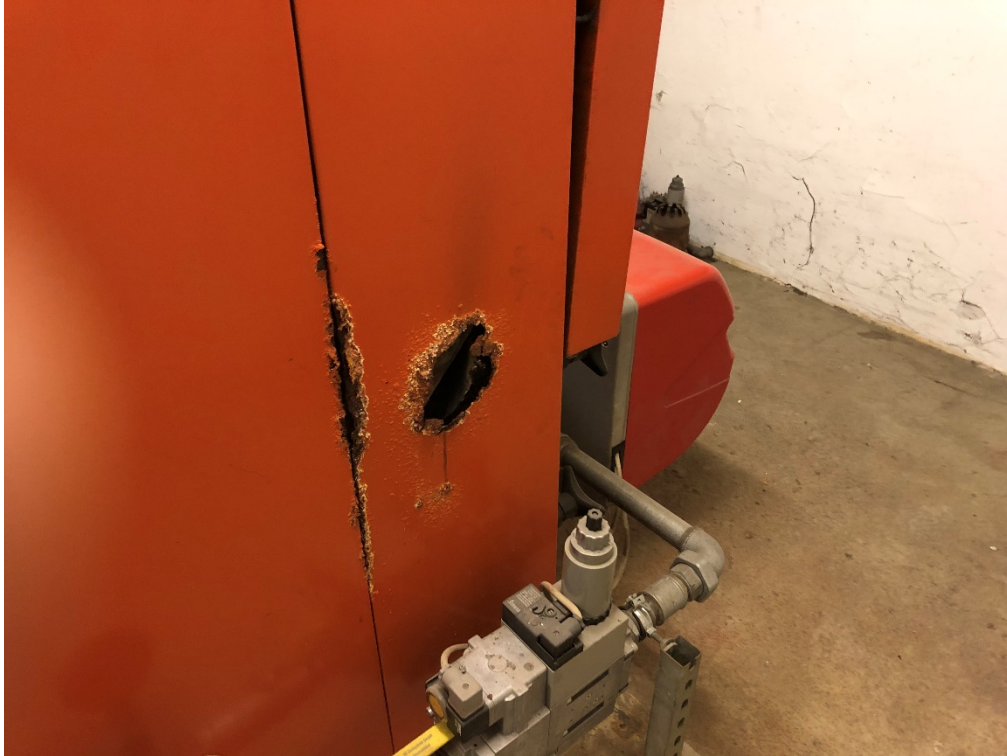
Abbildung 1 - Durchrostung am Bestandskessel
