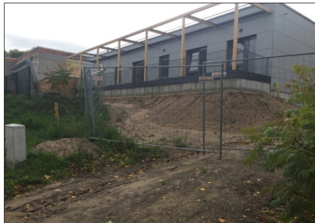
Straßenseite / Rückseite Erweiterungsbau
