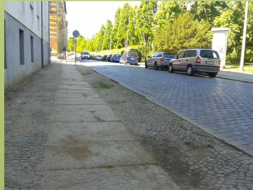
Der südliche Gehweg ist für Fußgänger die Haupteinschließung der Wohnbebauung sowie der KITAs. Er weist insbesondere zwischen der Lessing- und der Gerichtsstraße sehr große Schäden sowie starke Unebenheiten auf, in einigen Bereichen liegt die Gehbahn bis zu 10 cm tiefer als der Fahrbahnrand. Diese Schäden verringern die Benutzbarkeit sowie die Verkehrssicherheit insbesondere für die Kinder sowie für Menschen mit Behinderung.
