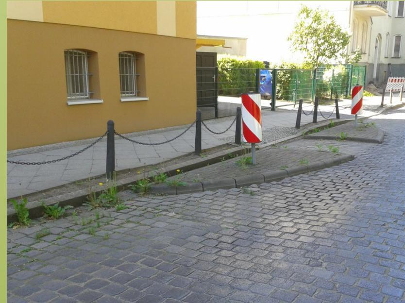
Durch die Bauweise der Einengungen kommt es ganzjährig zu Ablagerungen von Unrat und Laub im Fließgerinne entlang der Borde sowie zu verstärktem Pflanzenwachstum im Umfeld der Einengungen. Dieses führt zu Abflussbehinderungen und in deren Folge zu Überstauungen im Bereich der Gehwegquerungen. Die Verunreinigungen sind nur aufwändig mittels Handarbeit zu beseitigen, der Erfolg dieser Arbeiten ist dagegen nur von kurzer Dauer.
