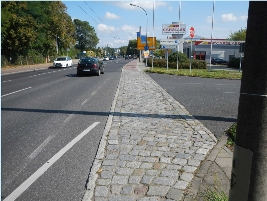
Bild 5: Zufahrt Parkplatz Familiengarten, die Führung des Radfahrers erfolgt auf dem Streifen aus Natursteinpflaster; Blickrichtung Osten
