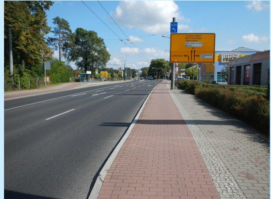
Bild 6: Bestandsanlagen am Ende der Baustrecke Blickrichtung: Osten
