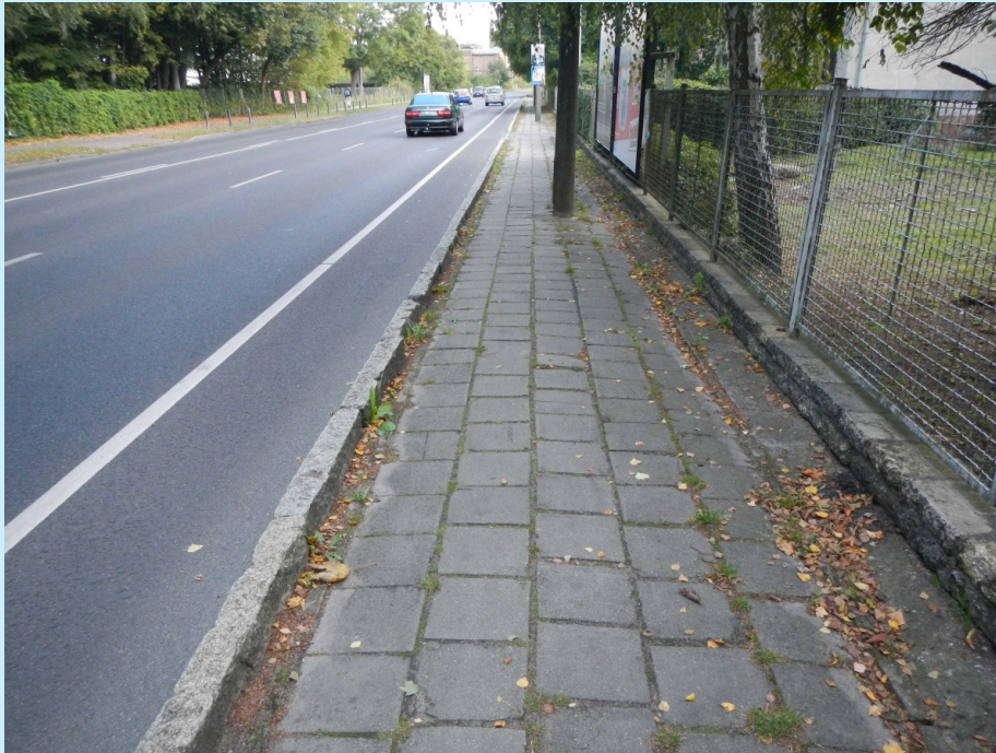
Bild 3: Behelfsgehweg hinter auskragendem Hochbord; Blickrichtung: Osten
