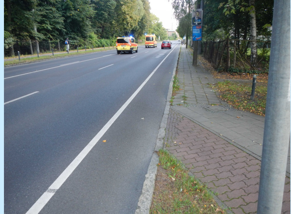
Bild 2: Übergang vom vorhandenen getrennten Geh- und Radweg auf den Behelfsgehweg; Blickrichtung: Osten
