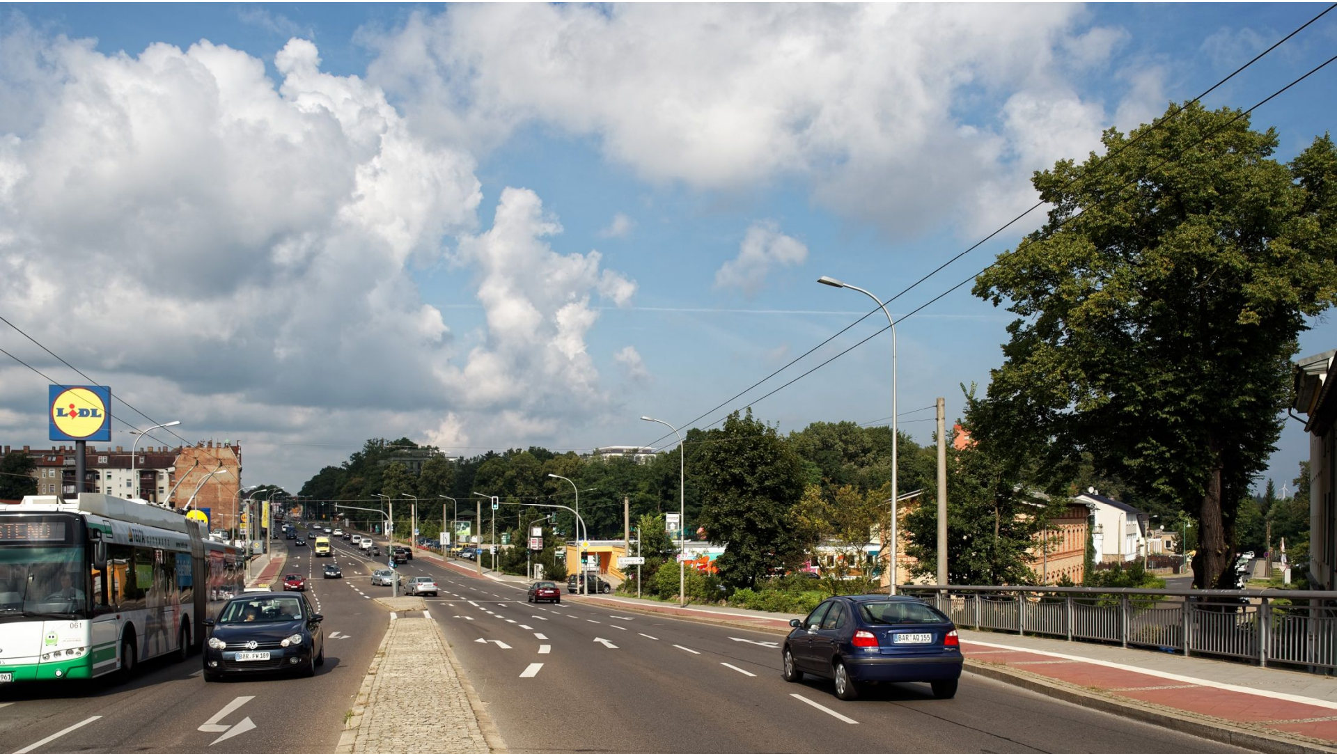
Blick von Ost / Brücke Bahnhof
