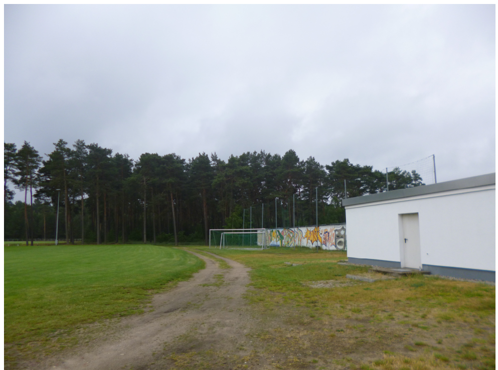
WC- Anlage Bestand
