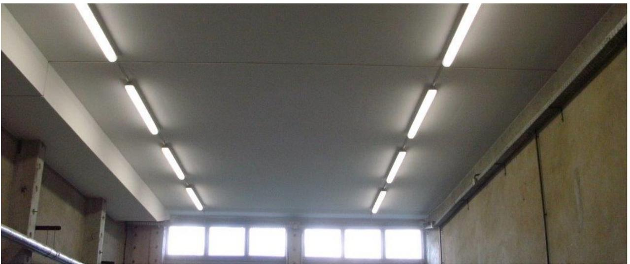
Abbildung 12 Abgehangene Zwischendecke und LED-Innenbeleuchtung
