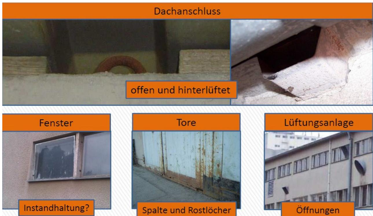
Abbildung 10 Zustand der Fahrzeughalle vor der Sanierung (Quelle: Bessel & Bagans, 2012)
