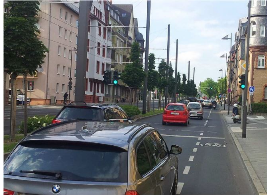
Beispiel – Frankfurt am Main, Friedberger Landstraße; Quelle: RNK Eberswalde
