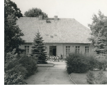
Schulgebäude in der Kirchstraße 8 1960 bis 1997
