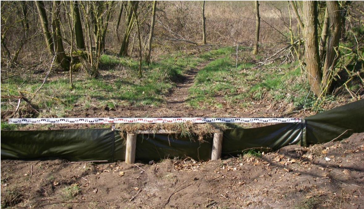
**Abbildung 2-1: Zäunung im Bereich einer Rampe mit Stützkonstruktion**
