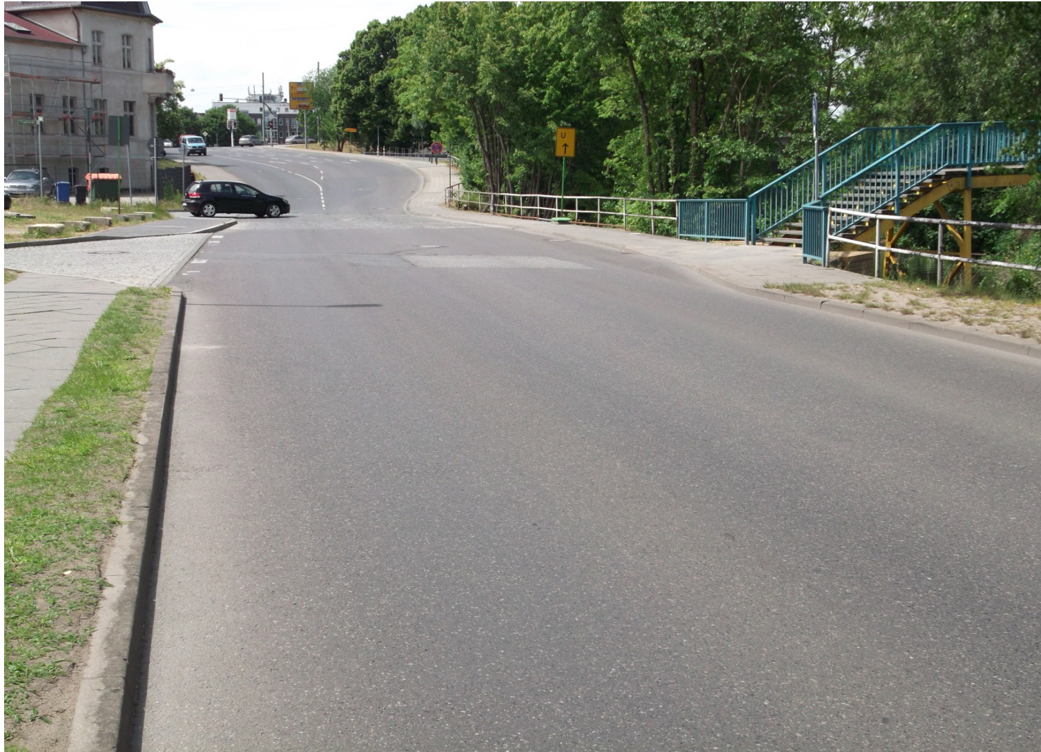
Blick aus Bollwerkstraße in Richtung Knotenpunkt
