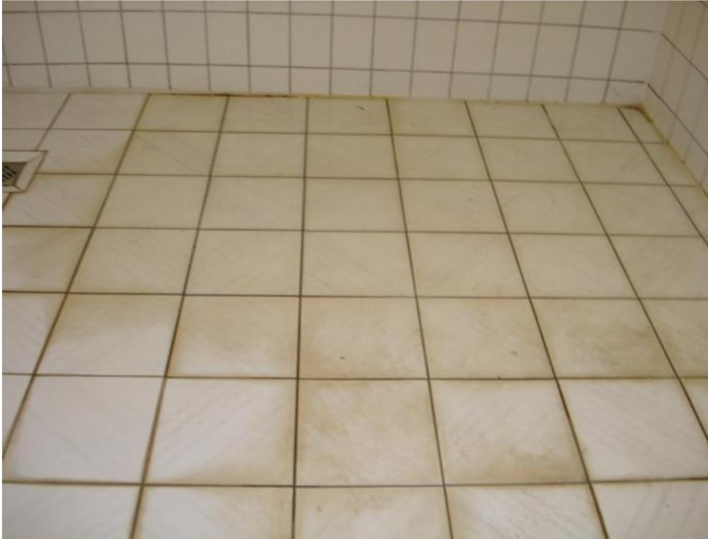
***Bild 9: Funktionsgebäude Waldsportanlage, Duschen (Wasser steht)***
