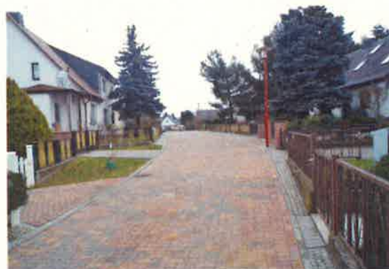
Abb. 2: Gutenbergstraße - nach der Straßenbaumaßnahme
