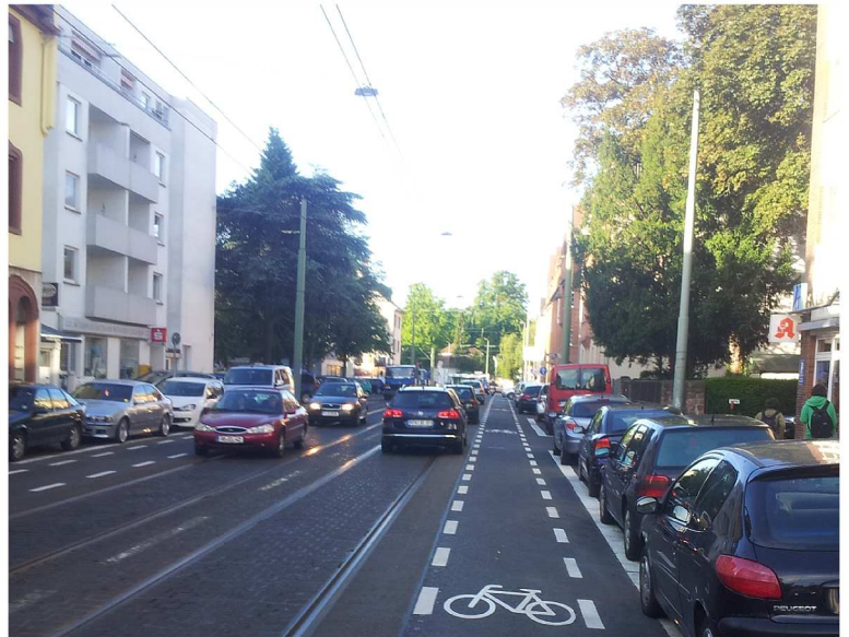
Abbildung: Schutzstreifen in Frankfurt am Main
