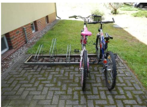
*Anlage mit ungeeigneten Felgenklemmern ohne Witterungsschutz*
