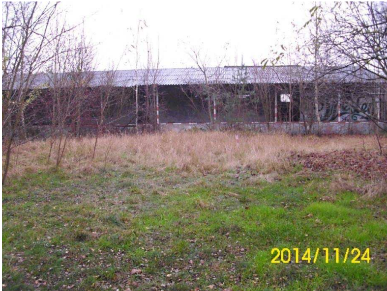
Abbildung 7: Landreitgras-Flur (hinten) in Flurstück 2044 (Teilfläche B)
