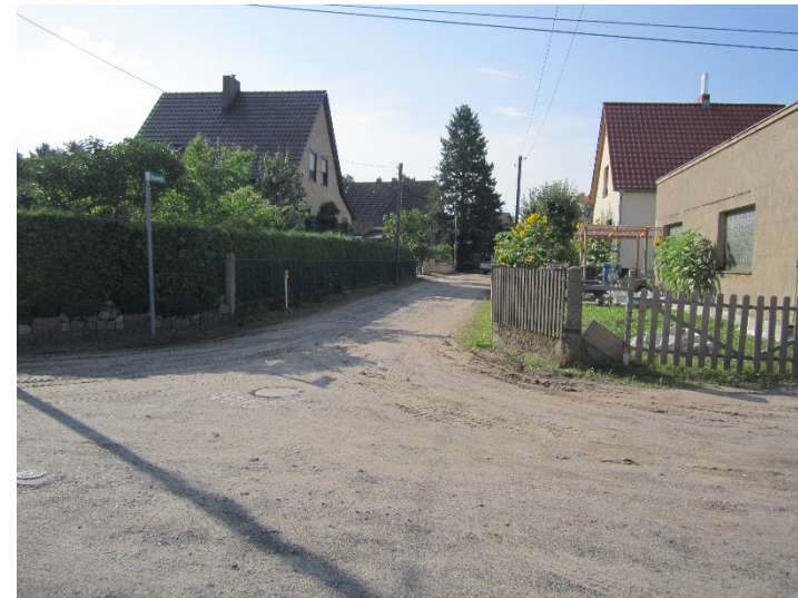
Abb 6: Knotenpunkt Kiefernweg/Kastanienweg [Bauende]
