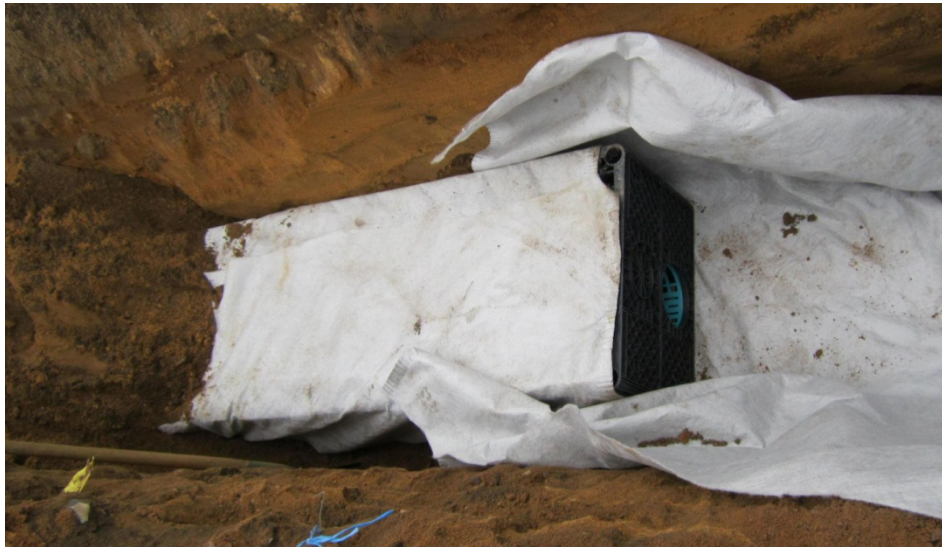
Abb 17 und 18: Rigolenfüllkörper beim Einbau
