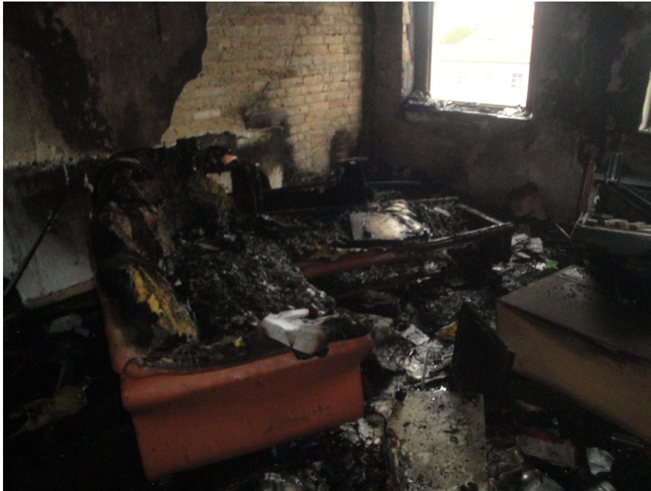
Gleicher Wohnungsbrand Innenansicht
