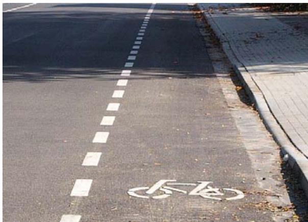
Abb. 26: Bsp. eines Schutzstreifens
