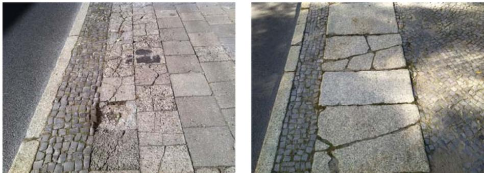
Abb. 14: Oberflächenschäden im Gehweg
