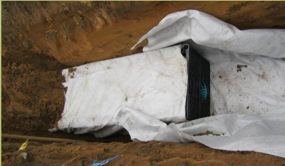
Abb 16 und 17: Rigolenfüllkörper beim Einbau
