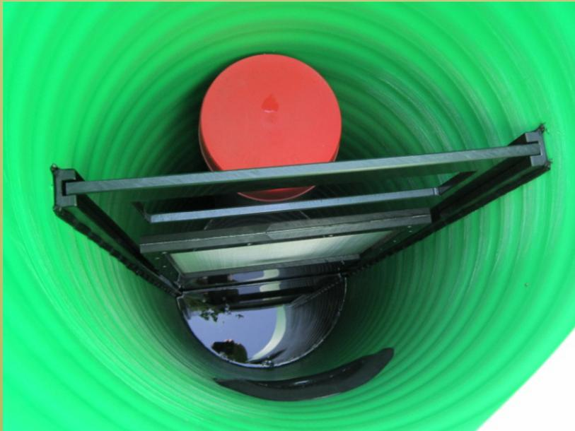
Abb 14 und 15: Reinigungsschacht einer Rigolenentwässerung
