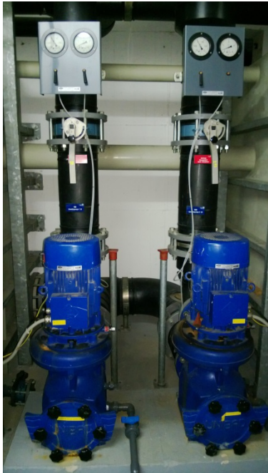
Beckenwasserpumpen
