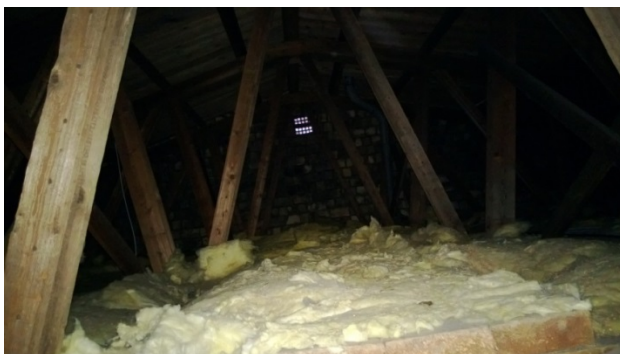
Dämmung Geschossdecke Flachbau
