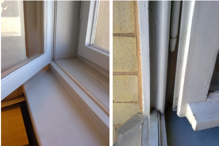
Doppelkastenfenster mit Dichtgummis
