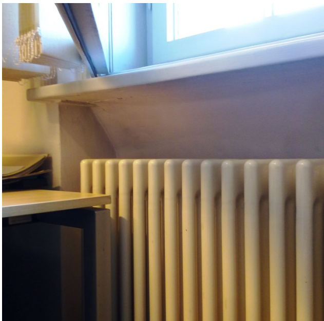
Ungedämmte Heizkörpernische
