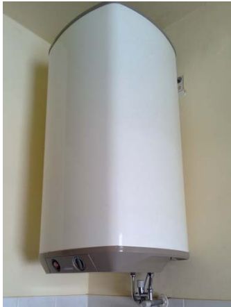
Elektro-Warmwasserbereiter/-speicher
