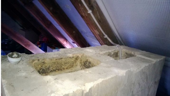
Offener Schornsteinzug im Kaldach
