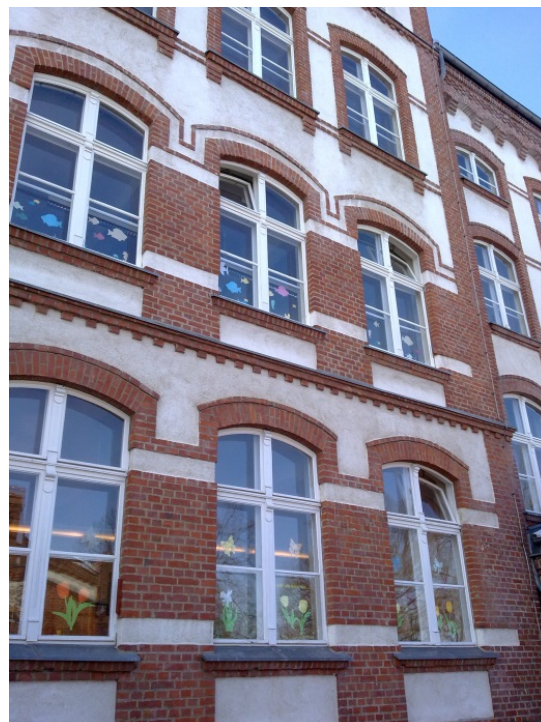
Kipp Lüftung im Winter
