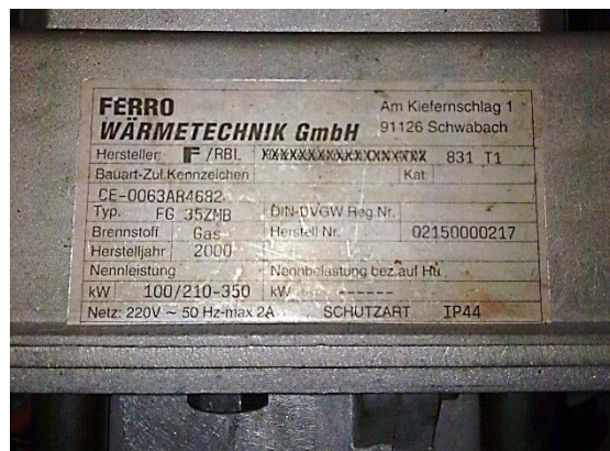
Typenschild Brenner
