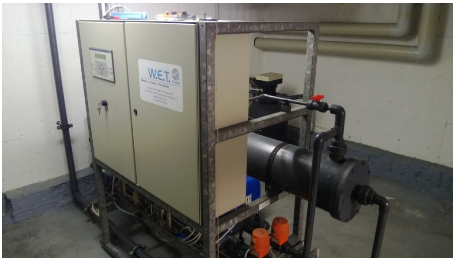
Spülwasser-Aufbereitungsanlage
