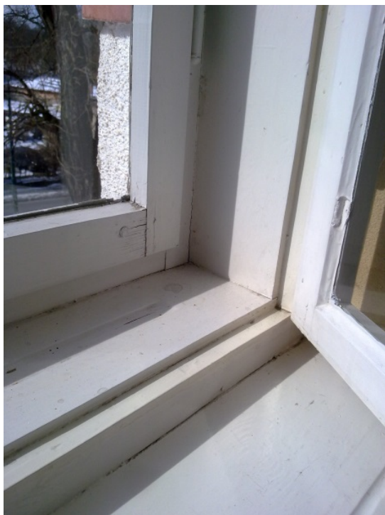
Kastenfenster ohne Dichtung
