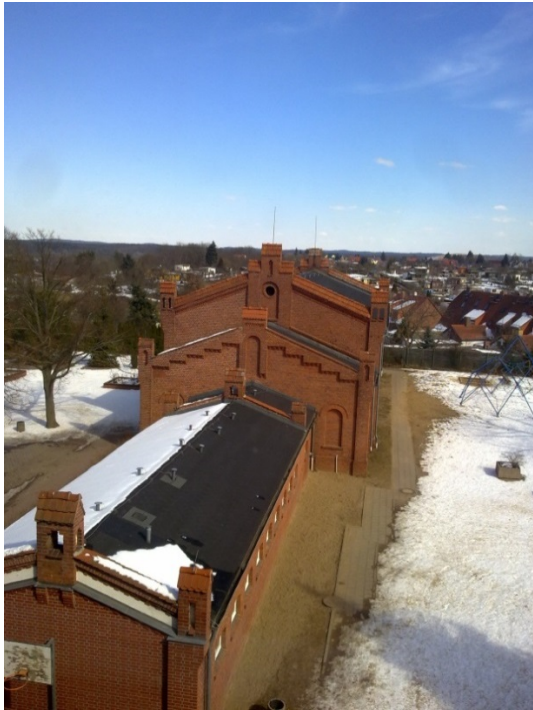
Möglicher Aufstellort PV-Anlage
