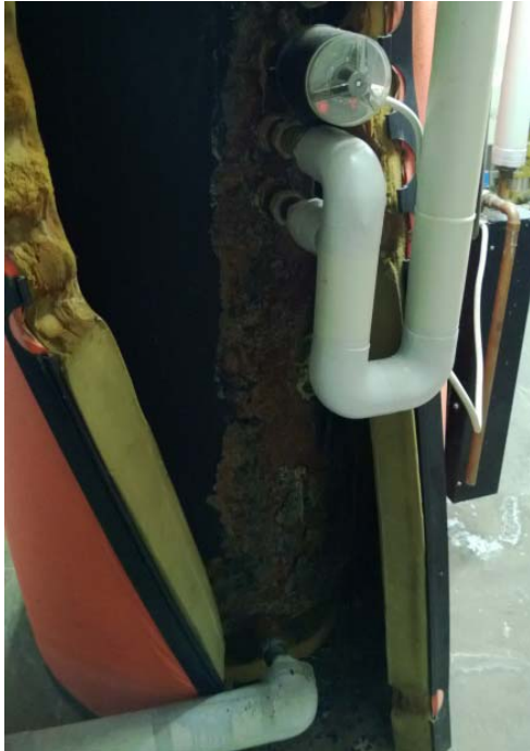
Offene Speicherdämmung
