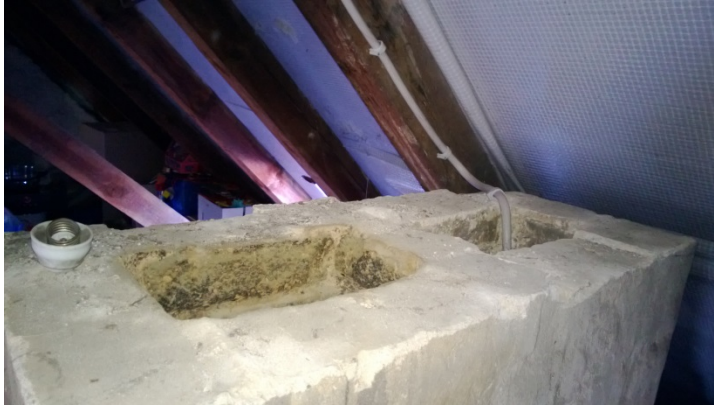
Offener Schornsteinzug im Kaltdach
