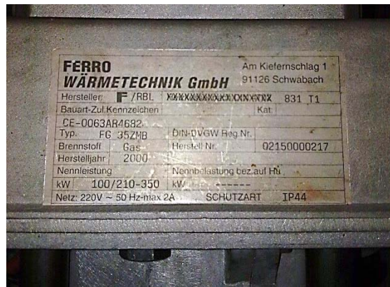
Typenschild Brenner
