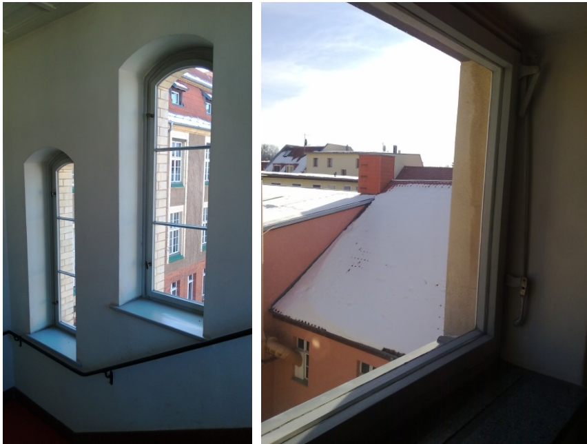
Einfachverglasung im TH Zweifachverglasung mit schlechtem U-Wert
