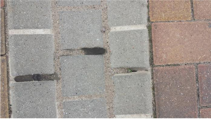
ebenfalls beschädigte dauerelastische Fuge
