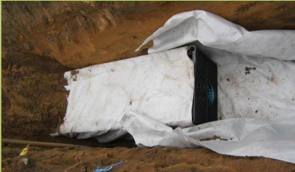
Abb 26 und 27: Rigolenfüllkörper beim Einbau
