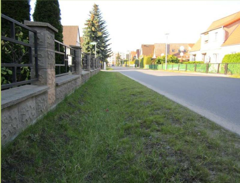
Abb 22 und 23: Beispielgestaltung Muldenentwässerung
