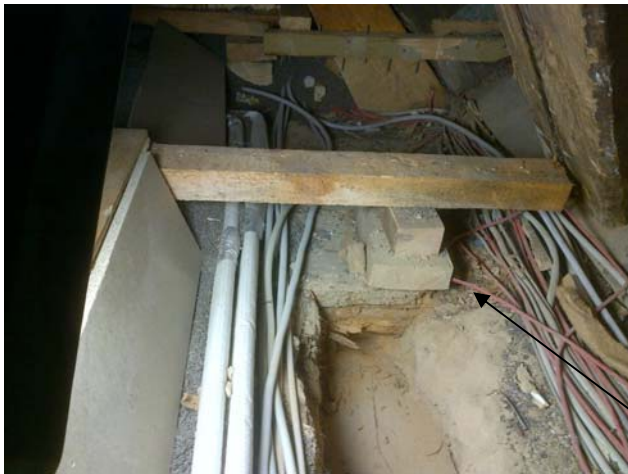
Falsche Unterkonstruktion
