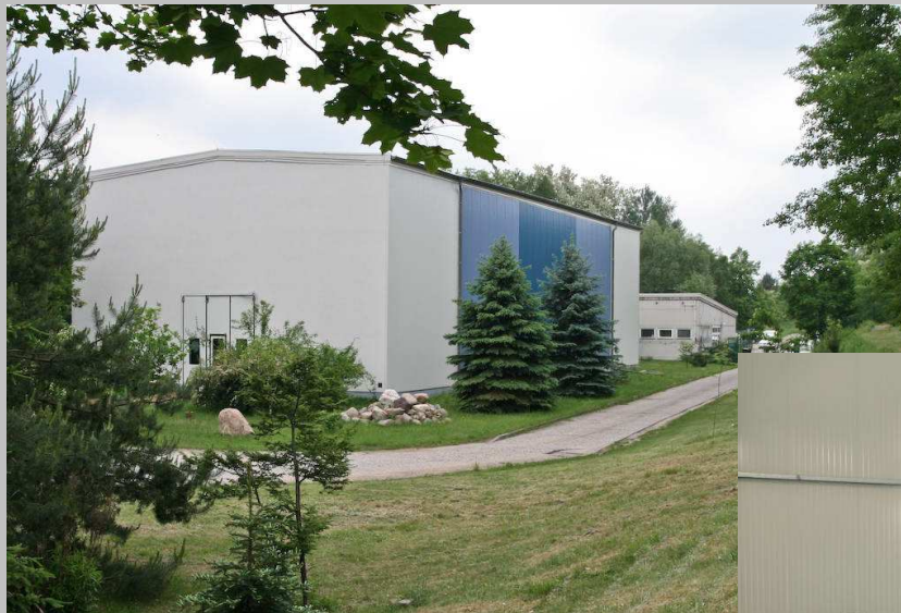
Wasserwerk Finow - Außenansicht Filterhalle -
