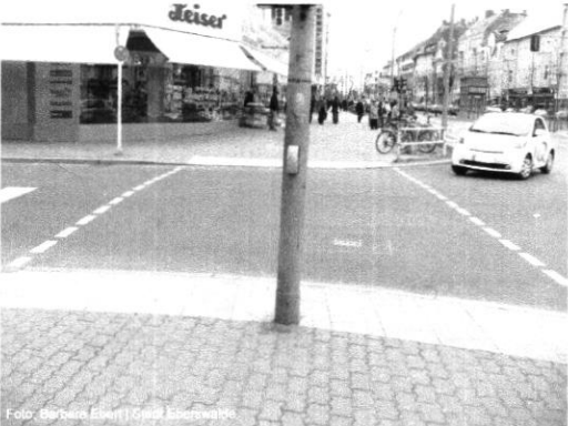
😊 Korrekt angelegte Querungsstelle, Bordsteinabsenkung auf 3 cm
