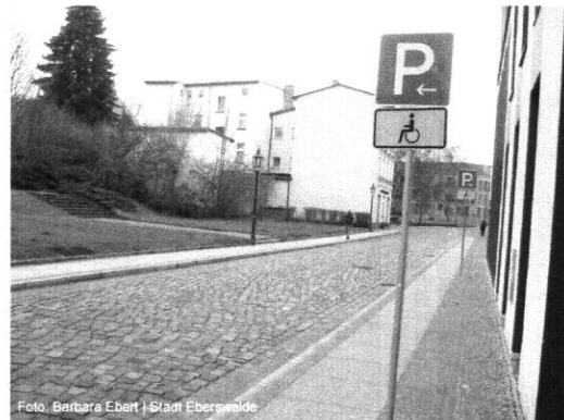
☹ Straße mit mehreren behindertengerechten Stellplätzen, ohne Bordsteinabsenkungen
