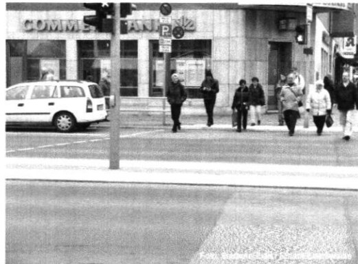
😊 Querungsstelle mit Mittelinsel, Bodenindikatoren und Absenkung auf 3 cm
