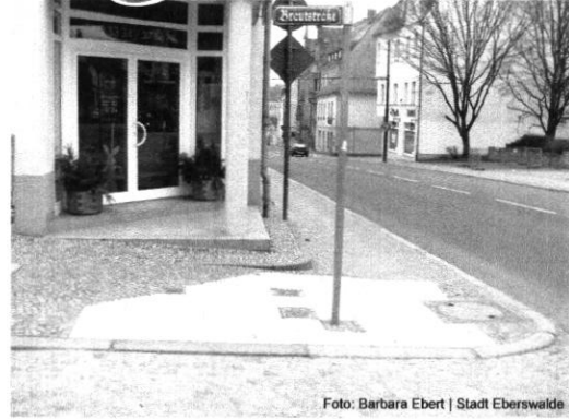
☹️ Verbauter Teil einer Querungsstelle
