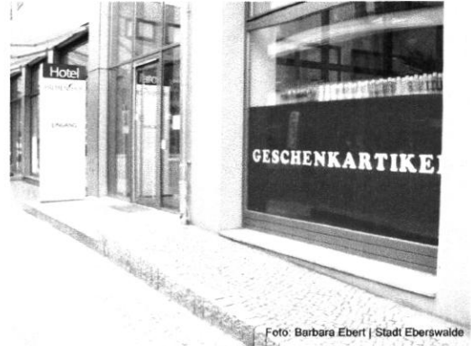
☹ „Rampe“ mit Absturzgefahr
