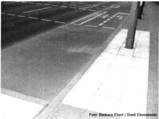
😊 Fachgerecht angelegte Querungsstelle mit davorliegendem Radweg und breiten Haltestreifen
