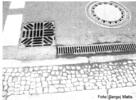
☹️ Querungsstelle mit diversen Hindernissen und Nullabsenkung
