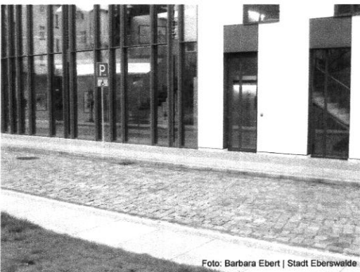
☹ Straße mit mehreren behindertengerechten Stellplätzen, ohne Bordsteinabsenkungen
