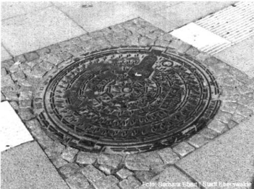
☹ Leitlinie, durch Gully- deckel unterbrochen
