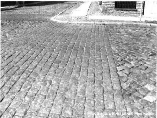
☺ Vorbildlich verlegtes Pflaster an Querungsstelle
