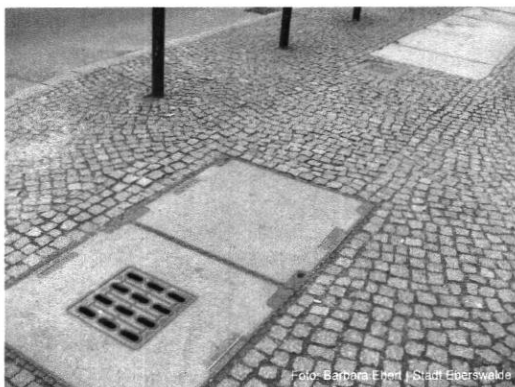
☹ Unterbrechung der Gehbahnmarkierung - fehlende Mobilitätskette
