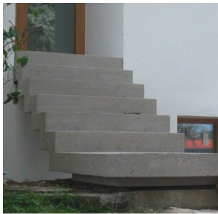
Betonfertigteil für Freitreppe
