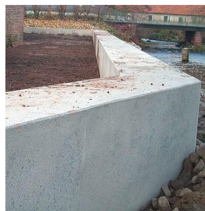
Mauerkopf zur Spundwand
